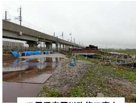
JR周辺安原川改修工事中
